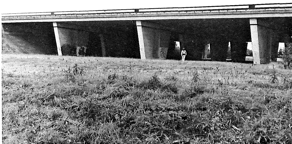
Het viaduct onder de A28.
